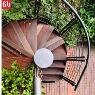
Außentreppe Privathaus in Essen 2007 Stahl feuerverzinkt und lackiert, Stufen aus Bankirai
