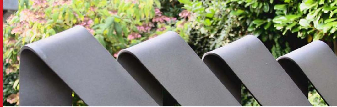
◆◆◆ **Toranlage an einem Privathaus in Essen, 2007.** Stahl warm verform, feuerverzinkt und lackiert. Die Flachstähle mit den Abmaßen 100 x 6 mm wurden um 45° gebogen und nicht sichtbar miteinander verbunden. Als Griff dient eine aus dem Flachstahl erzeugte Rolle über dem Schloß.
