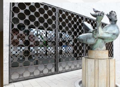
Die außen sitzenden Messingelemente wurden gegossen, gefärbt und mit Wachs beschichtet. Um dem Diebstahl und den Souvenirjägern in Bezug auf die Entfernung der Messingelemente zuvorzukommen, wurden die Messingelemente mit speziellen Zweilochschrauben von hinten befestigt.
